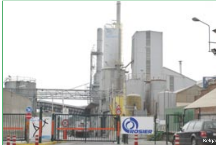
24 oktober 2007 – Er ontstaat brand in de Rosier-plant in Moustier. Het rampenplan wordt afgekondigd want het betreft hier een Seveso-II-bedrijf. Het vuur was snel onder controle. Een school en woningen in de buurt werden geëvacueerd.
